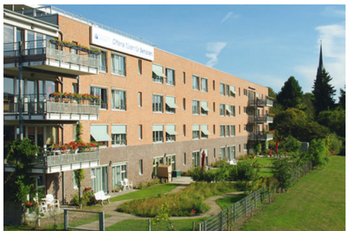
► Abb. 2 Lotti-Tonello-Haus Lübeck. Quelle: Vorwerker Diakonie gGmbH [rerif]
